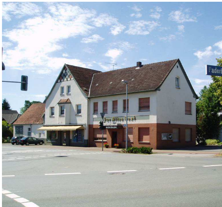
Ehem. Gasthaus Zur Alten Post (teilweise Leerstand)
