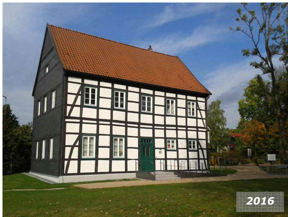
Baudenkmal Küsterhaus nach der Sanierung
